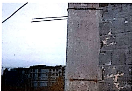
شکل (۳): استفاده از شاخک اتصال در فواصلی از ستون که به کمربند دور ستون جوش می‌شود.
